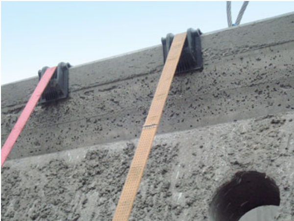
Bild 181: Einsatz von Kantengleitern
