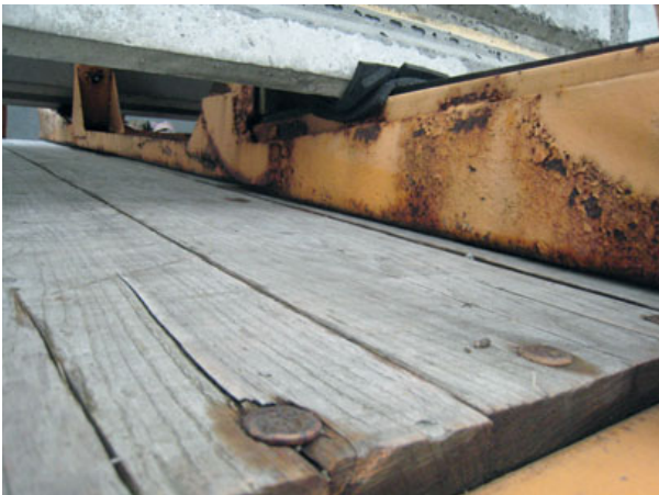
Bild 182: Fehlendes RHM unter dem A-Bock
