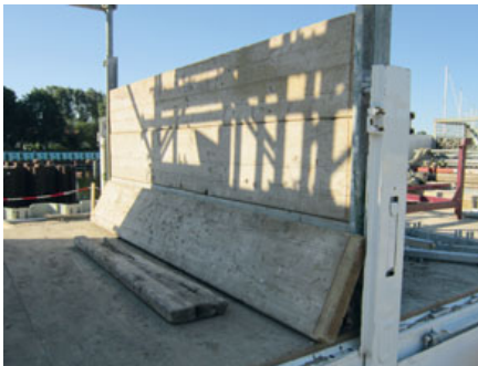
Bild 161: Stirnwand aus Gerüstbohlen
