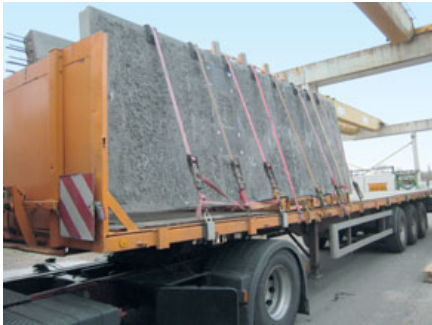
Bild 175 und 176: Transport von Betonfertigteilen auf A-Böcken
