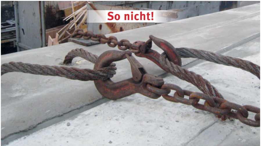
Bild 45: Drahtseilösen zum Heben von Betonfertigteilen als nicht zugelassene Zurrpunkte genutzt.
